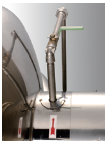
攪拌軸部殺菌・洗浄装置
