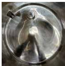
タンク上部からの様子
